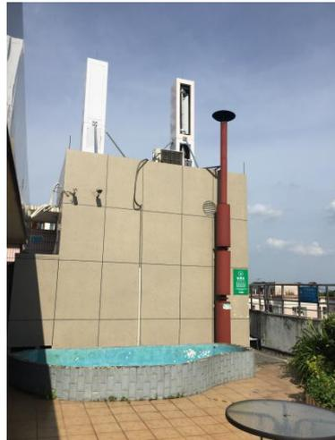
柴油备用发电机：经水喷淋引至楼顶高空排放
